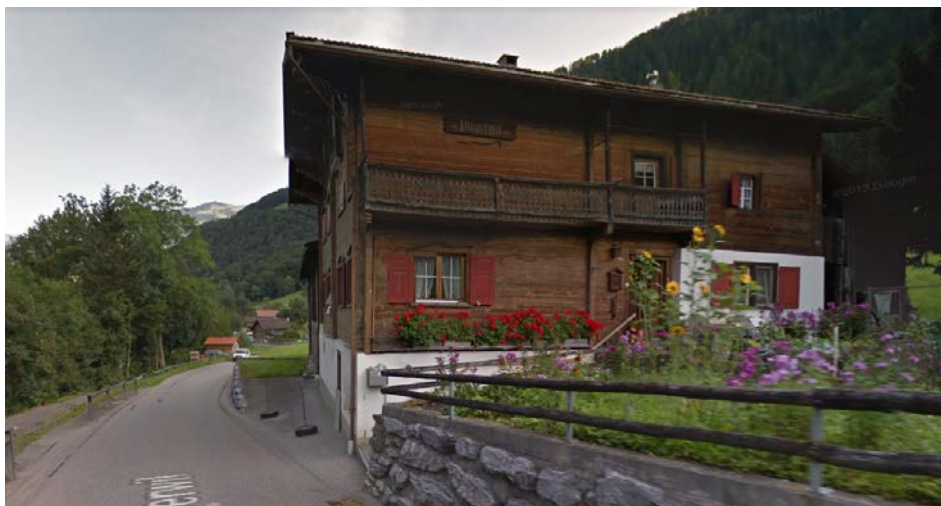
Abb. 1: Ansicht bestehende Einfahrt, Sichrichtung Schiers (Google Street View, 2014)
