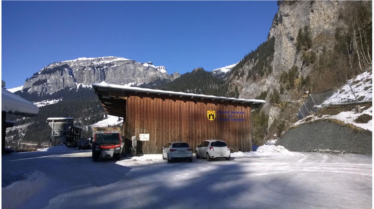
Bestehender Forstwerkhof und Werkhof in Trin - Gebiet Porclis
