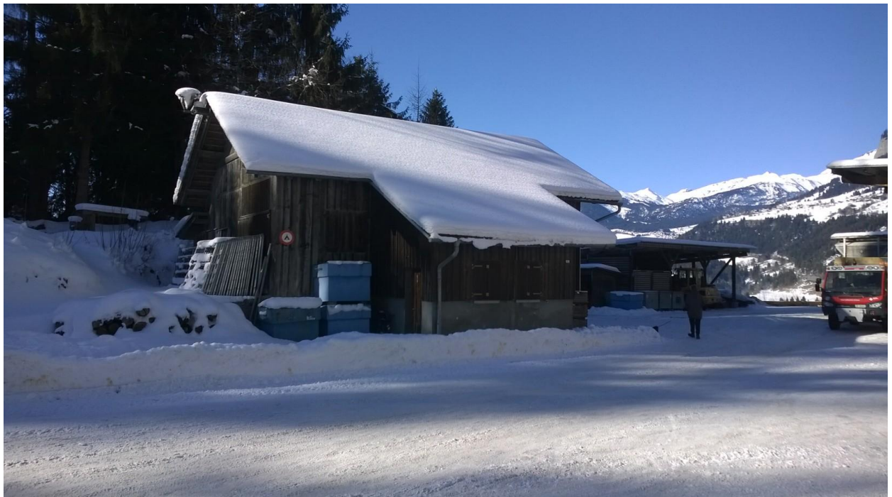
Bestehendes Werkhofareal mit Scheune - Gebiet Porclis
