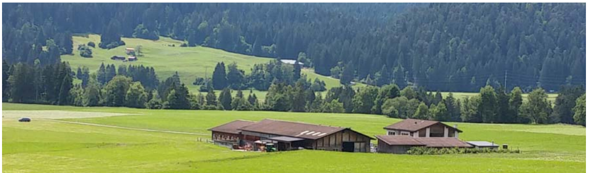
Nordostansicht: Einbettung der Aussiedlung mit Ausrichtung des Ökonomietraktes in der Falllinie des Geländes.
