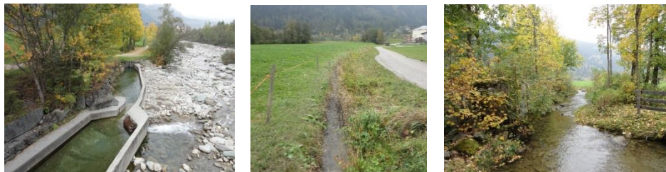
Abbildung 7: Mühlbach Einlaufbauwerk (links), nicht renaturierter Abschnitt (mitte) und renaturierter Abschnitt (rechts) der als Vergleichsstrecke diente.
