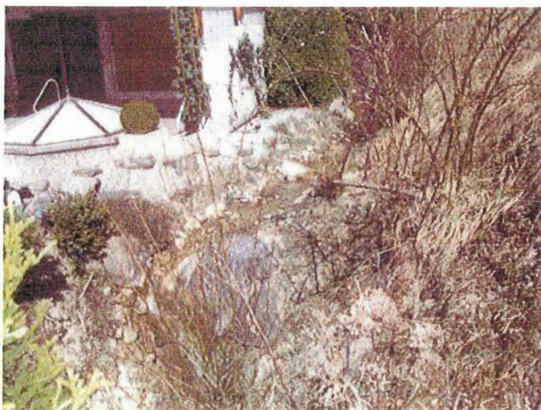
NEUE AUSFÜHRUNG BEI BACHUMLEGUNG
