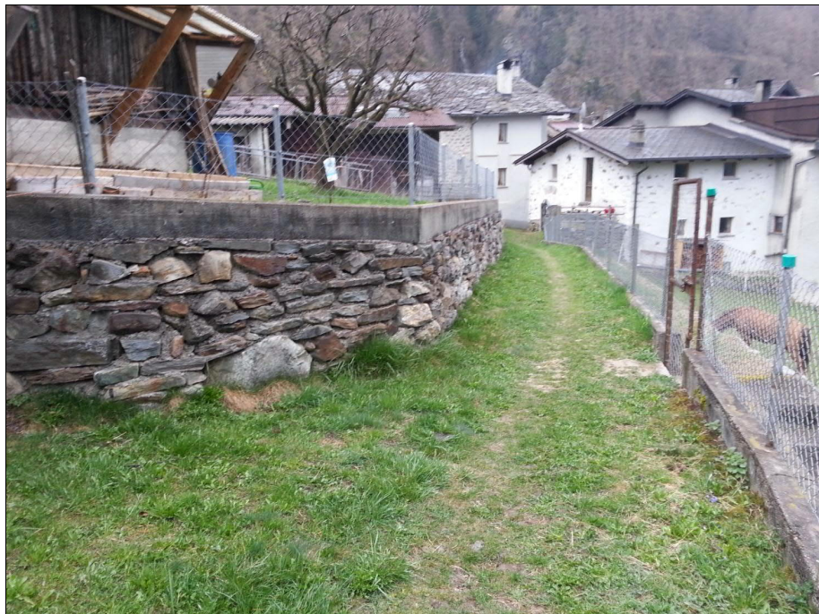
Foto del viale pedonale a sud dell'edificio n. 505
