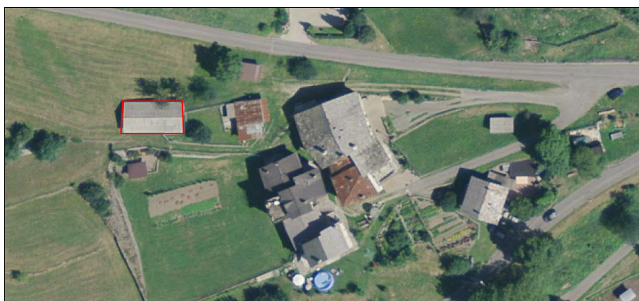
Ortofoto con evidenziato da un perimetro rosso l'edificio n. 505
