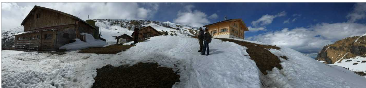
Abb.: Foto vom Standort; links das Ökonomiegebäude, in der Mitte im Hintergrund das bestehende Wohnhaus, rechts oben das mit der Teilrevision der Ortsplanung 2008 (vgl. 1.1) ermöglichte Wohnhaus (Aufnahme vom 30.03.2016)
