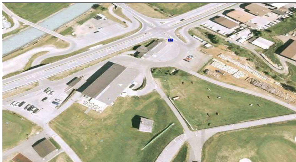
Abb.: Luftaufnahme des Gebiets „Resgia“ mit dem Sportshop, dem Clubhaus der Golfanlagen und dem Feuerwehrdepot der „Pumpiers Plaiv“
