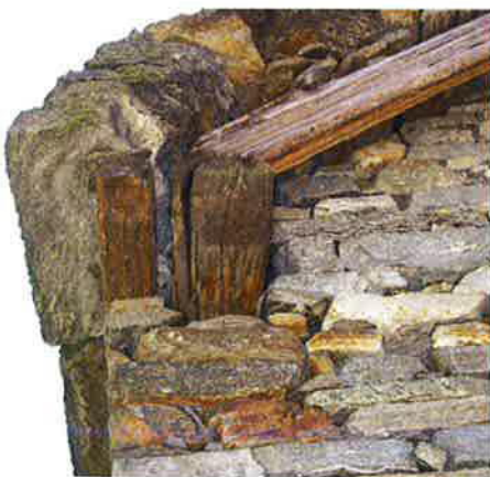
Lato di gronda frontespizio
