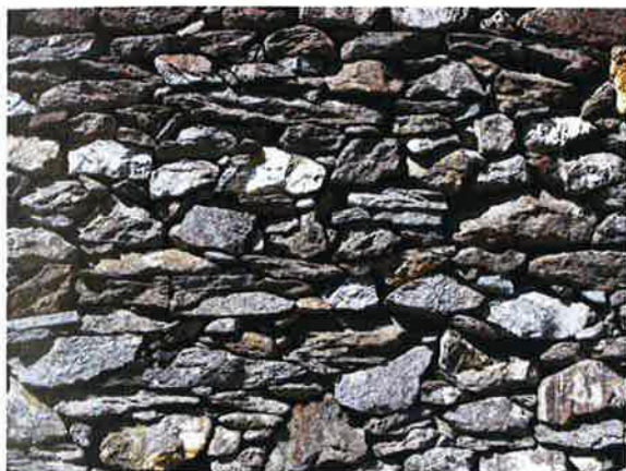
Muratura a secco
