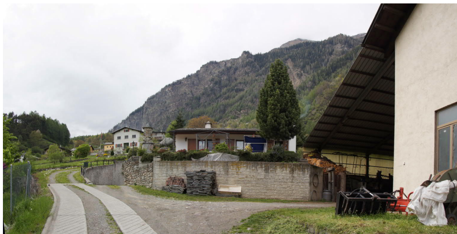
Foto dalla strada (direzione nord-est) verso l'edificio n. 471A, la tettoia 471A-B e gli spazi di pertinenza della struttura agricola
