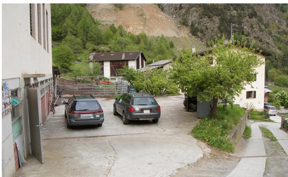
Foto degli spazi di pertinenza a sud dell'edificio n. 471A utilizzato a scopo agricolo
