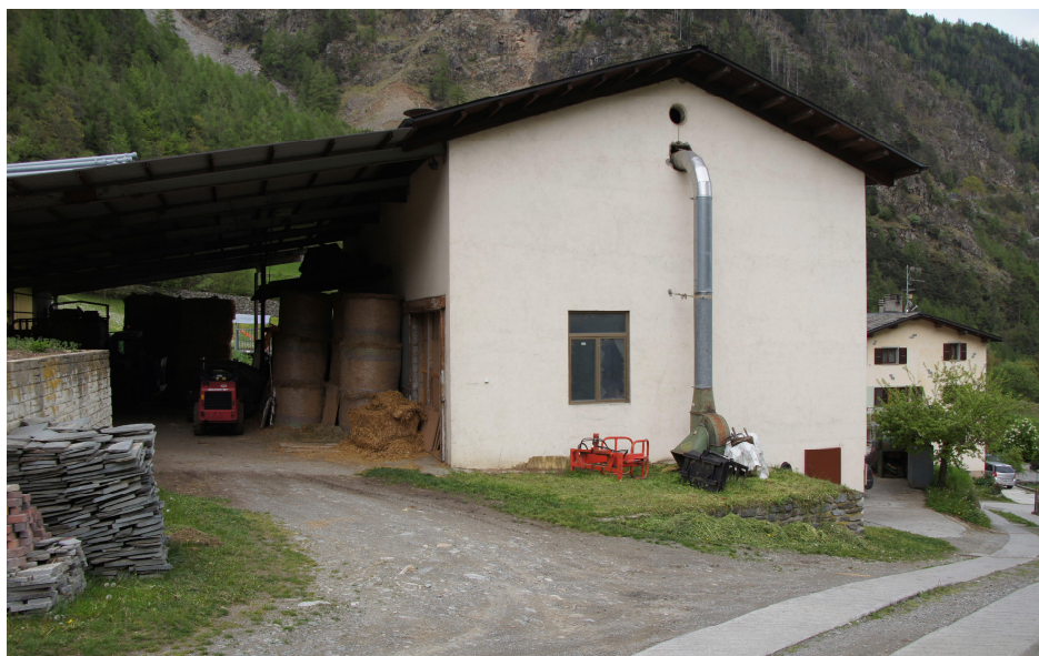
Foto dalla strada (direzione est) verso l'edificio n. 471A, la tettoia 471A-B e gli spazi di pertinenza della struttura agricola
