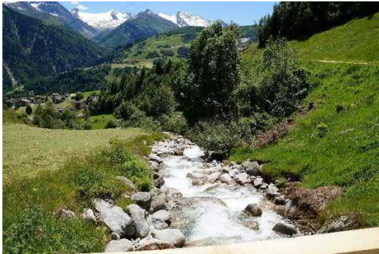
Abbildung 5 Lokaler Uferschutz bei Crap Gries. Blick in Fliessrichtung von der Brücke auf 1290 m ü. M.
