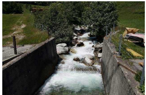
Abbildung 8 Einlauf in den Kanal von der oberen Zubringerbrücke der Talstation
