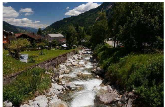
Abbildung 10 Gerinne zwischen der Brücke auf ca. 1200 m ü. M. und der Brücke Kantonsstrasse in Fliessrichtung betrachtet
