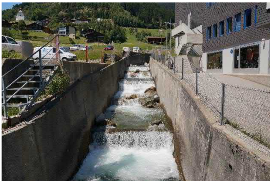
Abbildung 7 Kanal entlang der Talstation der Bergbahnen Disentis, Blick entgegen der Fliessrichtung von der unteren Zubringerbrücke aus (ca. 1245 m ü. M.)
