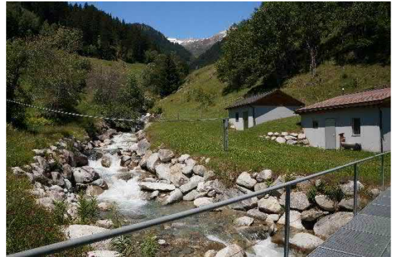
Abbildung 6 Blocksatz beim Reservoir. Blick entgegen der Fliessrichtung von der Fussgängerbrücke zum Reservoir (ca. 1245 m ü. M.)
