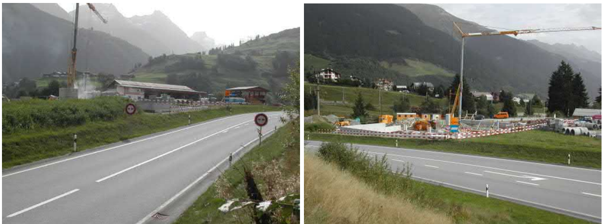
Abbildung 3 Gewerbezone Pignola: Baustelle Bezirkstiefbauamt, September 2008
