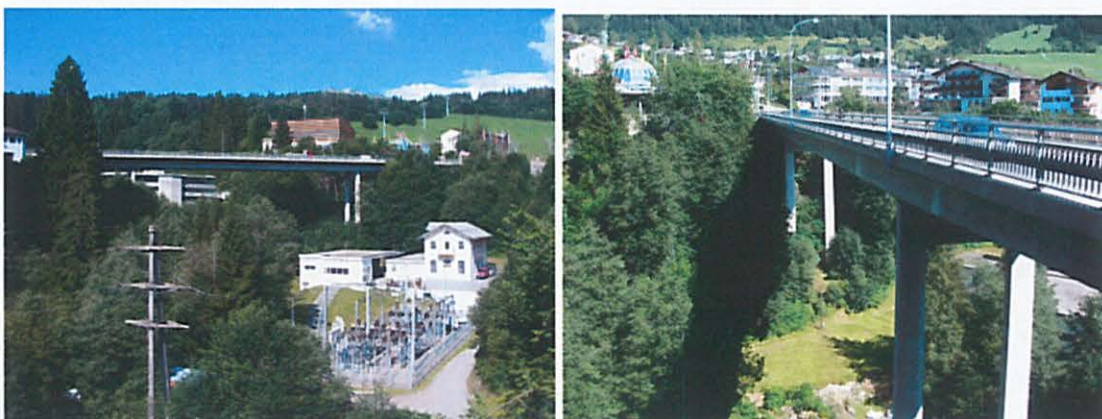
Abbildung 2 Unterwerk Stenna, Stennabrücke (links), zwischen Stennabrücke und Parkhaus (rechts)
