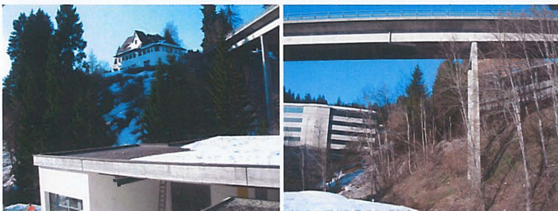
Abbildung 1: Liegenschaft Grischuna (links), Parkhaus und Brücke Stenna (rechts)
