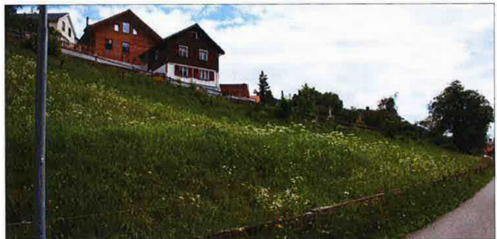
Abb. Parzelle Nr. 331 in Richtung Südosten, Erschliessung berg- oder talseitig möglich
