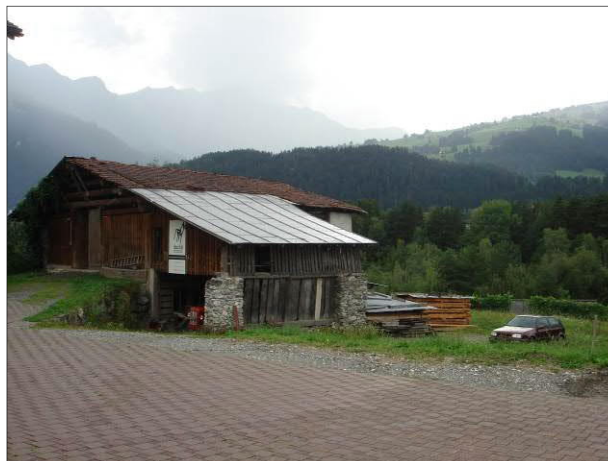
Abb. Standort Einzonung Teilparzelle Nr. 360 von Nordosten
