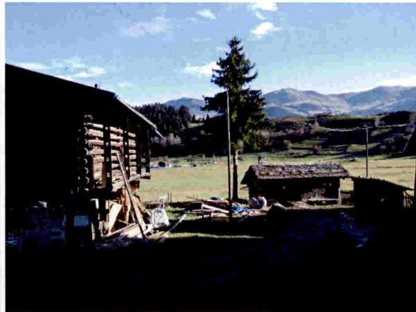
Links: Zum Abbruch vorgesehene Baute
