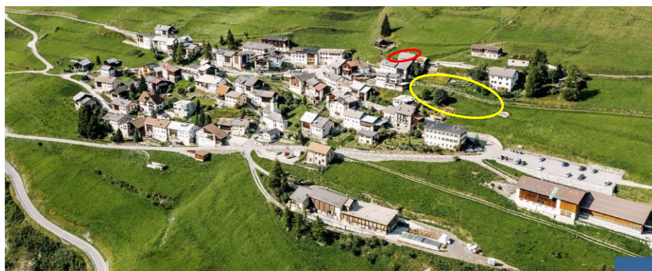
Abb. 14: Ansicht Vnà (Quelle: ISOS), gelb = Baustandort Truoi, rot = Baustandort Favgia
