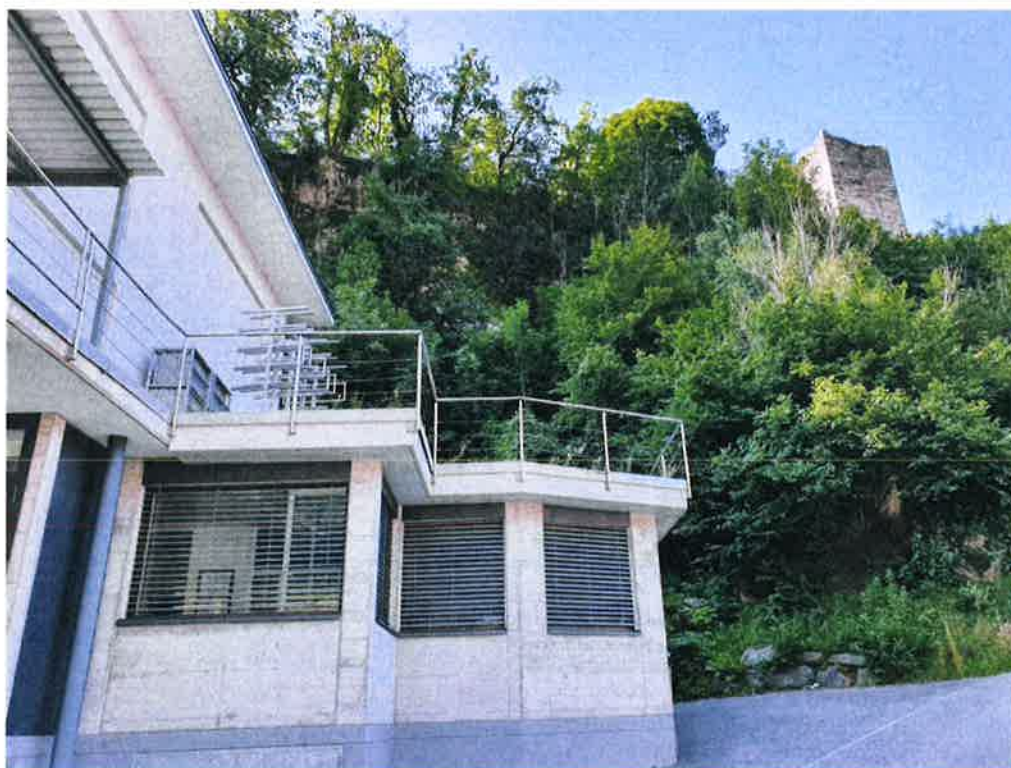
Ansicht des von der Erweiterung der „Gurtner AG Montenaro Fleischwaren“ betroffenen Gebietes. Teilweise werden die neu benötigten Räume auf diesem Vorbau realisiert.
