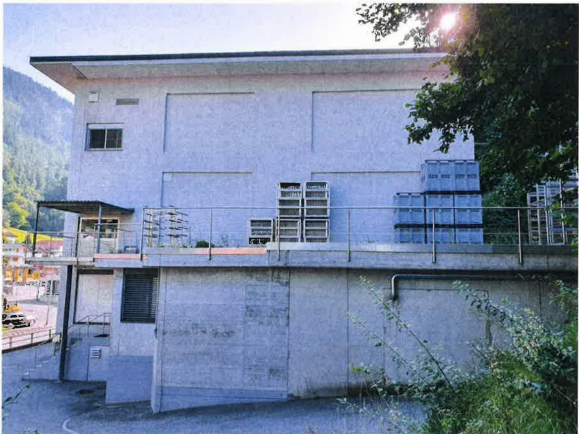
Fotoaufnahme der Fleischtrocknerei Gurtner in Trin (Westfassade des Betriebsgebäudes und Bereich der Änderung)
