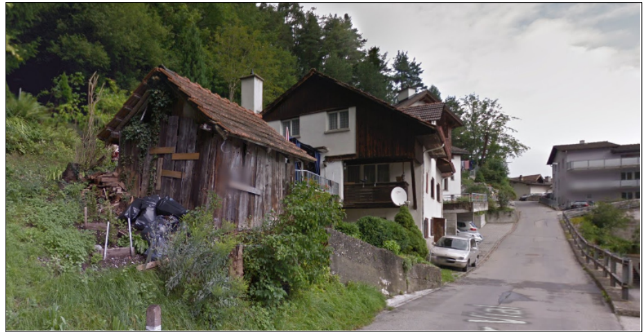
Abbildung 4: Bestehende Bebauung Blickrichtung Norden (Quelle: Google Street View)
