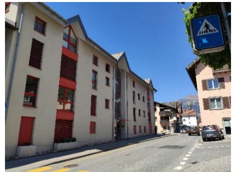
Abb. 18: Neuere Baute an der Kantonsstrasse
