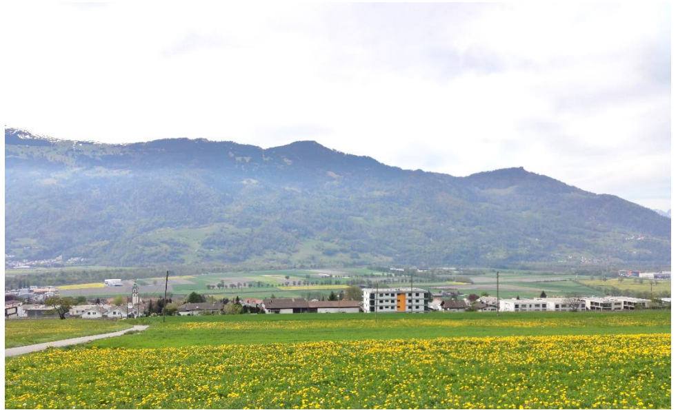
Abbildung: Ansicht Bergseitig; R+K
