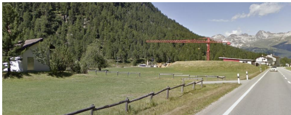
Abb. 6: Ansicht von Südosten
