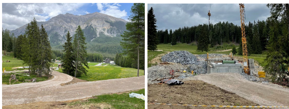
Abbildung 5: Bilder vom Bau der Rollskibahn im Sommer 2022
