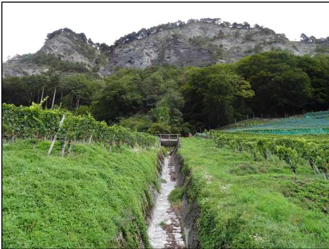
Blick hangaufwärts auf befestigte Rufensohle und Mauer, Foto R+K
