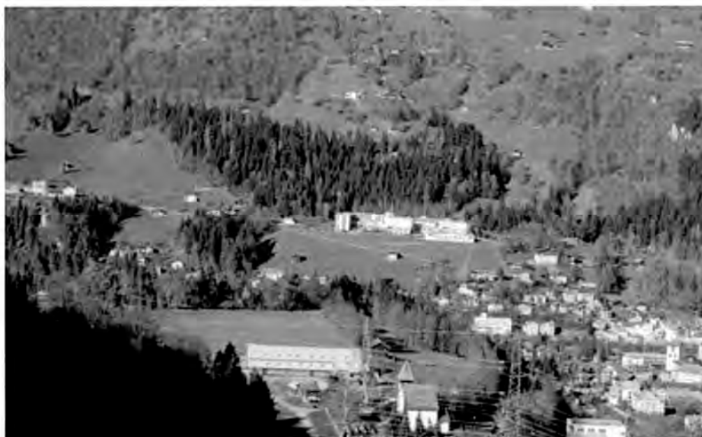
Vordergrund: Kapelle St. Martin und neue landwirtschaftliche Ökonomiebaute Hintergrund: Klosteranlage und die Siedlungsteile La Lutta und Quinclas
