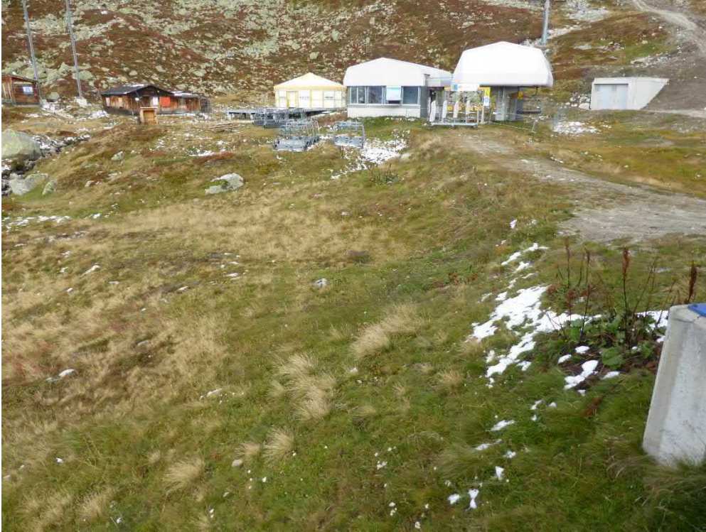
Fotostandort 1 Ecke SW Bergstation Sesselbahn 4. Oktober 2019
