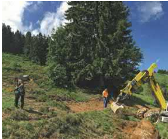
Abbildung 10 Piste im Bau, Flumserberg
