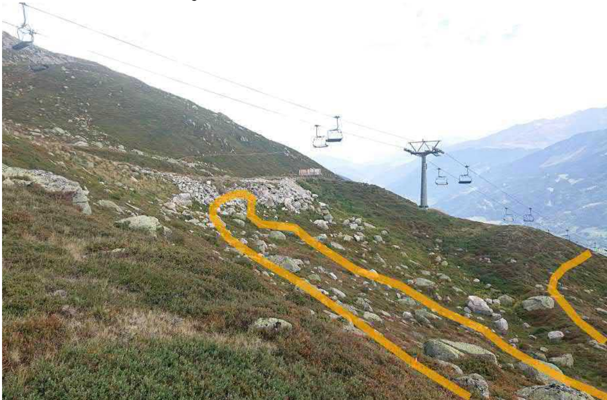
Bild: Typisches Gelände im Abschnitt 1 mit grobem Trail-Verlauf
