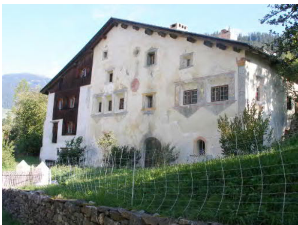
Abbildung 14: Haus Käppeli (rechter Hausteil) Parzelle 28
