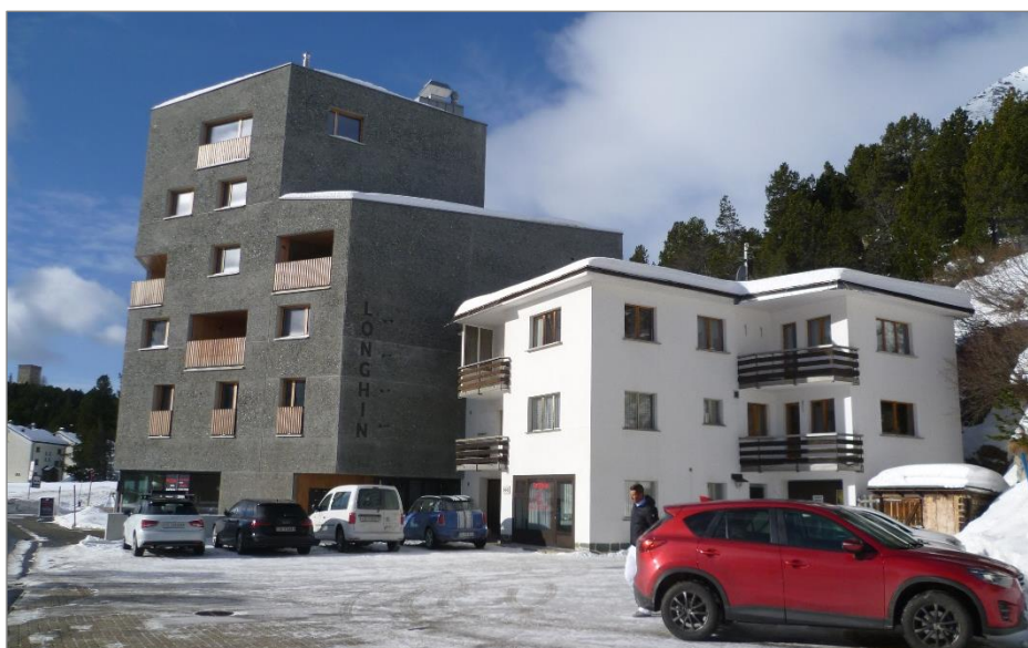
Immagine 1: Hotel Lunghin con annesso. (fonte: Architekten Tuena Hauenstein AG)
