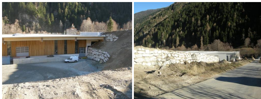
Abb. 2: Realisierte erste Etappe, (2015: Cumün da Val Müstair)
