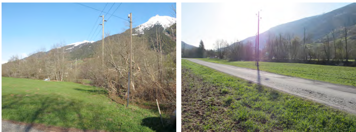
Abbildung 6: 60 kV-Leitung der Axpo im Bereich der geplanten Campingzone (links) und der geplanten Zone für öffentliche Anlagen (rechts)
